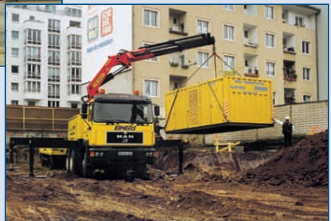
Entladung und Aufstellung
