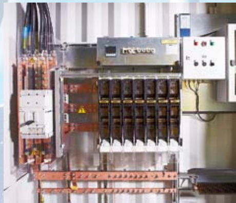
Niederspannungsgestützte Verteilung
