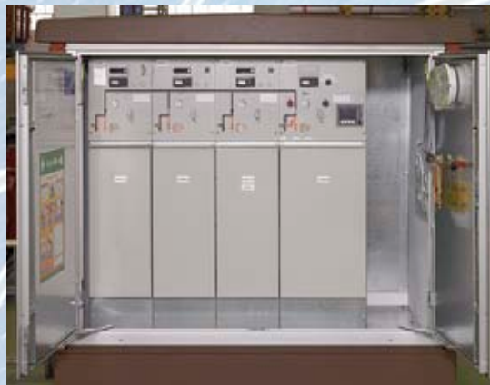
fernsteuerbare Mittelspannungsschaltanlage
