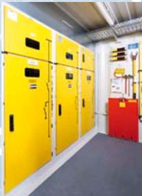
Mittelspannungsschaltanlage
