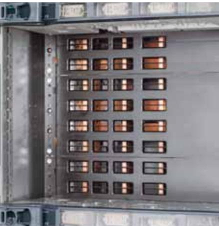
Steckschiensystem, prüffingersicher abgedeckt (IP20B).
