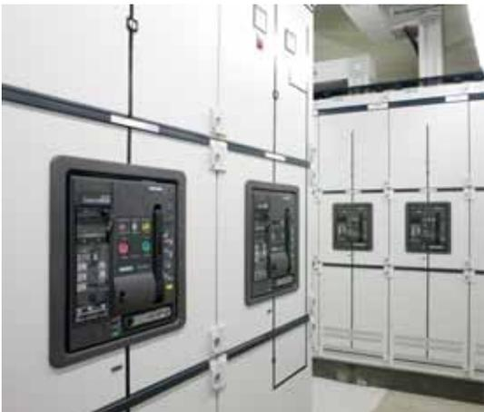
Die kompakte Bauweise sorgt für einen wirtschaftlichen Aufbau der SIVACON S8. Die flexible Wahl der Einbautechniken ermöglicht eine kompakte Gesamtlösung mit höchster Sicherheit.
